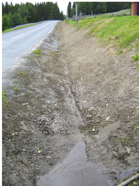
Att ta bort det översta, näringsrika jordlagret kan vara en metod för att skapa miljöer för arter som trivs med mer näringsfattiga miljöer
