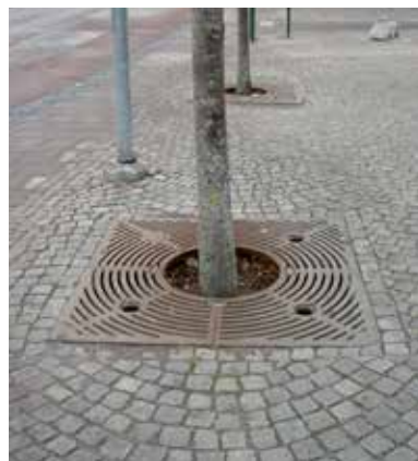
Lind i Linköpings stad med trampskydd runt stammen för att jorden inte ska bli för hårt packad av människofötter.
