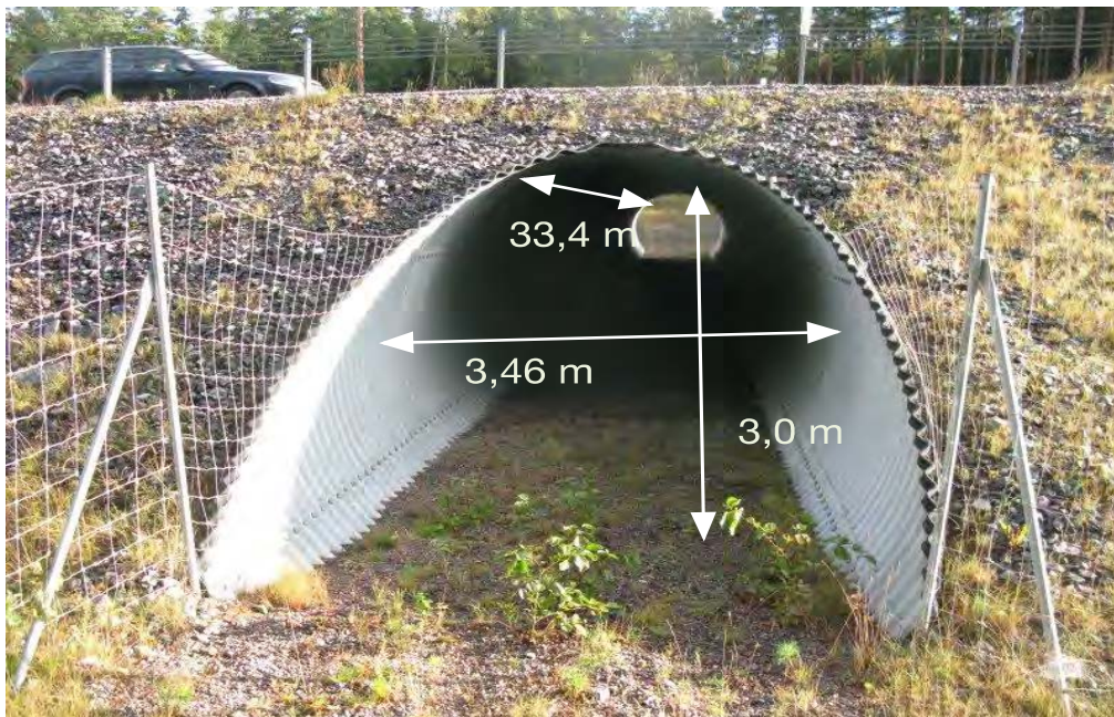
Figur 16. BaTMan Objekt 4-740-1: "Bro för E20 över gångstig vid Strängnäs" inkluderas i den följande effektbedömningen. Trumman är tillräcklig bred för älg (> 3m), men på grund av dess låga höjd och stora längd är öppenheten mycket liten: 0,31 = 3,0 * 3,46 / 33,4 . Passagen uppnår därmed bara en relativt låg effektivitet (13 % för älg och 28 % för rådjur). Foto: ur BaTMan
