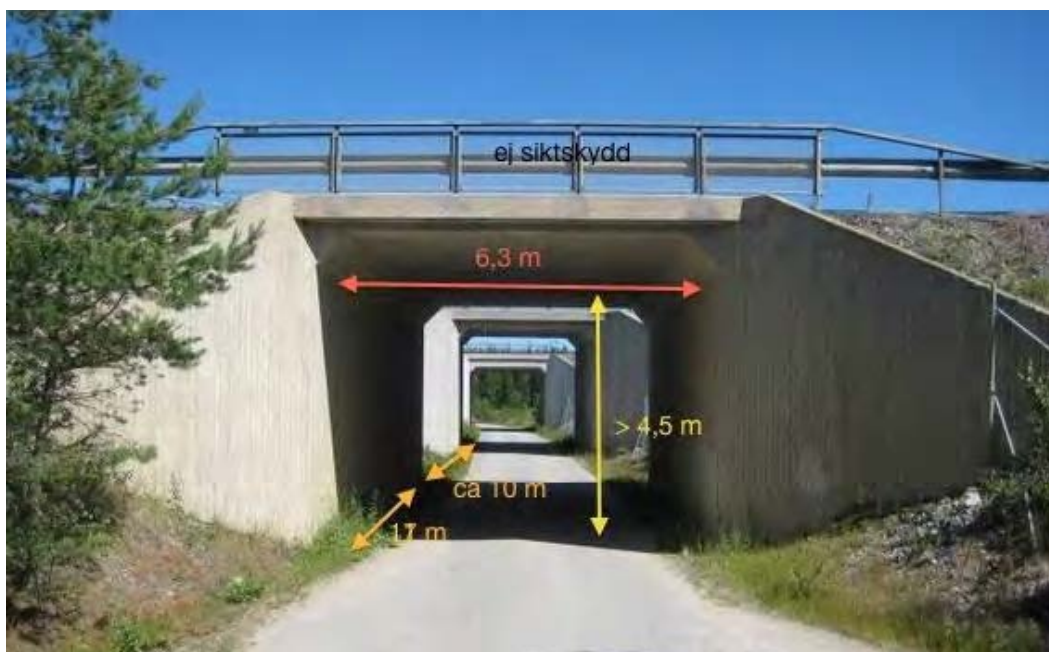
Figur 27. Broobjekt 4-496-1,2,3: Tre broar för E20 över enskild väg vid Mariefred. Tack vare det stora avståndet mellan broarna (> 10 m) bedöms varje objekt separat och därmed lämplig för klövvilt. Den samlade effektiviteten är dock troligen begränsad på grund av att djuren måste gå genom tre passager i rad. Foto: ur BaTMan.
