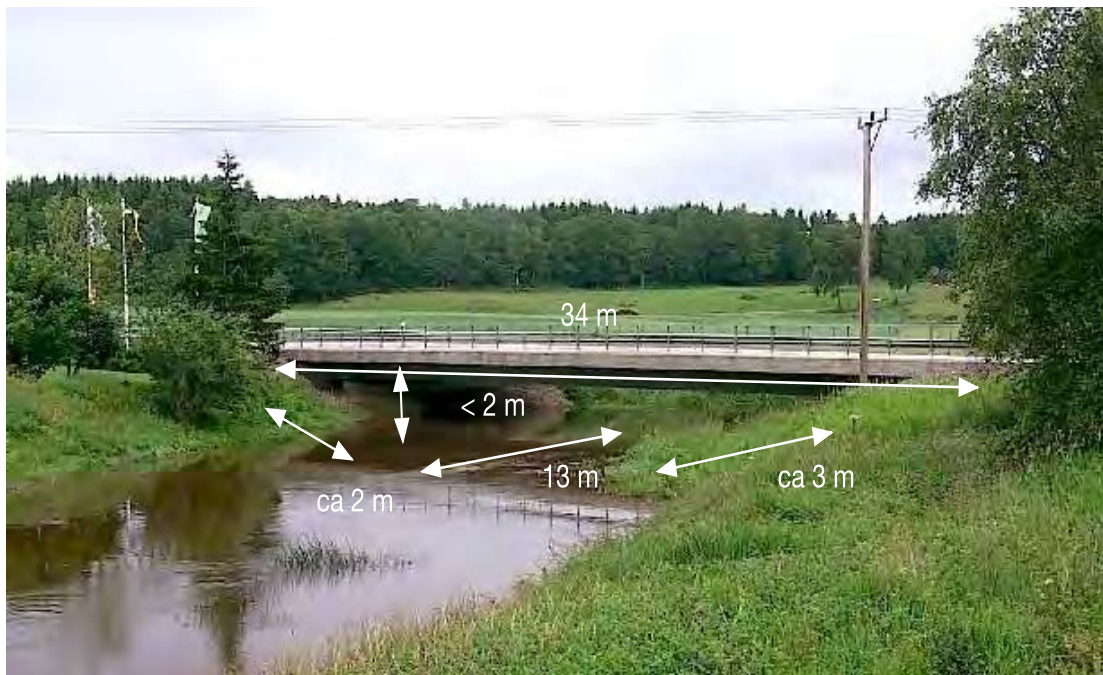
Figur 22. Objekt 15-1322-1: "Bro för E22 över Nossan vid Ribbingsberg". Strandpassagerna är för smala, branta och låga och bedöms därför som olämpliga för klövvilt. Foto: ur BaTMan.
