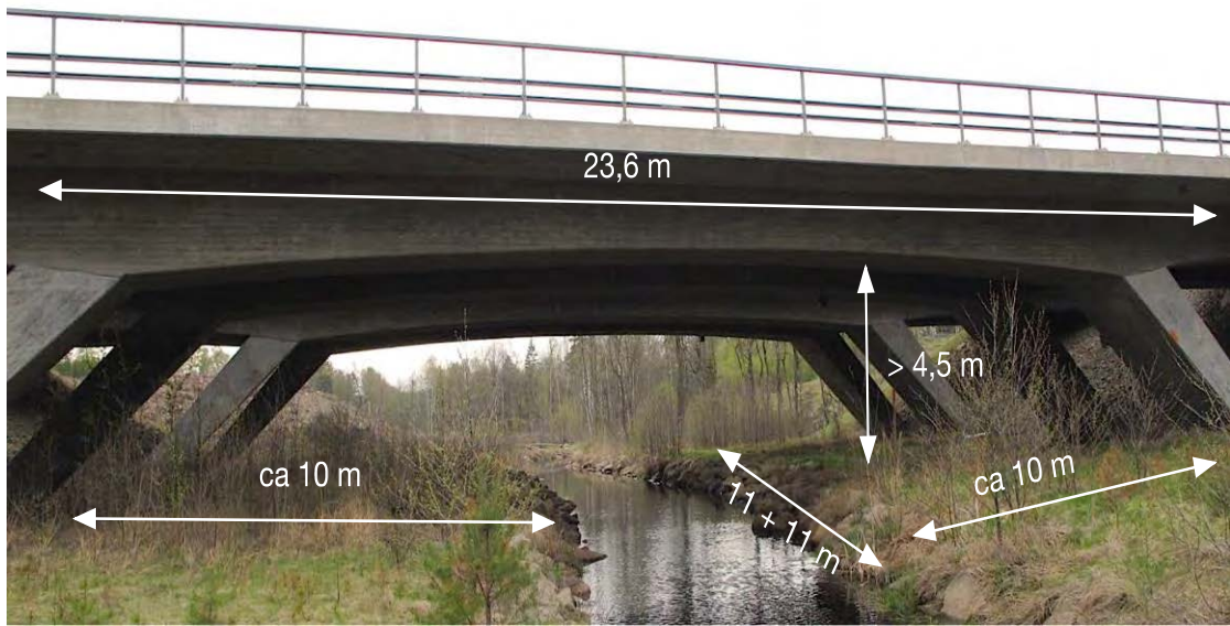
Figur 21. Objekt 11-940-1: "Bro för E4 över Lärkesholmsån vid Örskelljunga". Strandpassagerna längs ån är med ca 10 m tillräckligt breda och rymliga för att kunna fungera väl för klövvilt. Foto: ur BaTMan.
