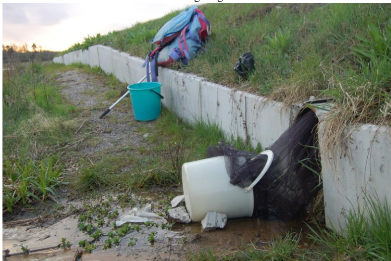
En fälla har monterats vid ett av rören vid Skårby. Fällan består av ett nät som spänts upp mot innerväggarna av röret med hjälp av fjäderstål. Hinken träs på utanför för att hindra att kråkor och andra djur upptäcker salamandrarna. På bilden syns också konstruktionen av ledarmen vid Skårby. Ledarmarna fungerar mycket bra och få salamandrar hittas på vägen mellan ledarmarna.
