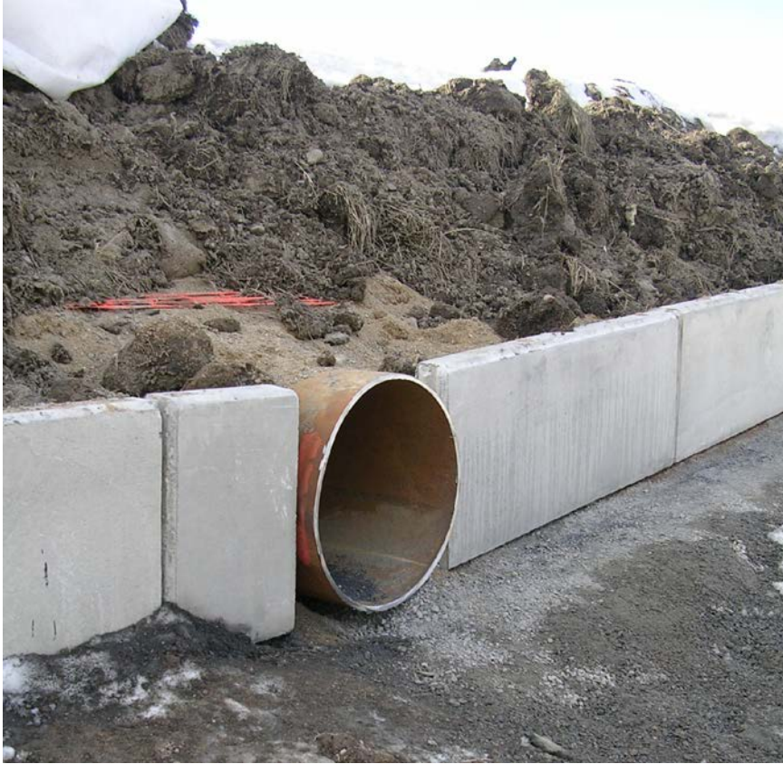
Trumma och ledarmar under konstruktion vid Skårby (Martin Larsson)
