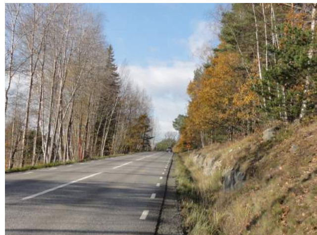
Bild 2. I västra delen av vägsträckan, på norra sidan, finns bergiga slänter. I dessa områden kan det bli komplicerat att anlägga trummor och barriärer.
