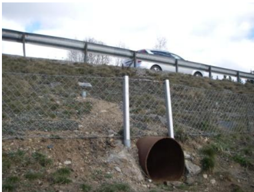
Bild visar rör i järn som går under bilvägen vid våtmarken
