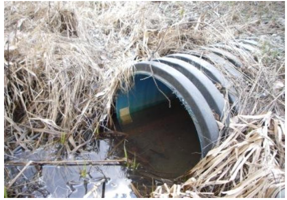
Bild av ett av de två plaströr som går under bilvägen vid sjön Tärnan
